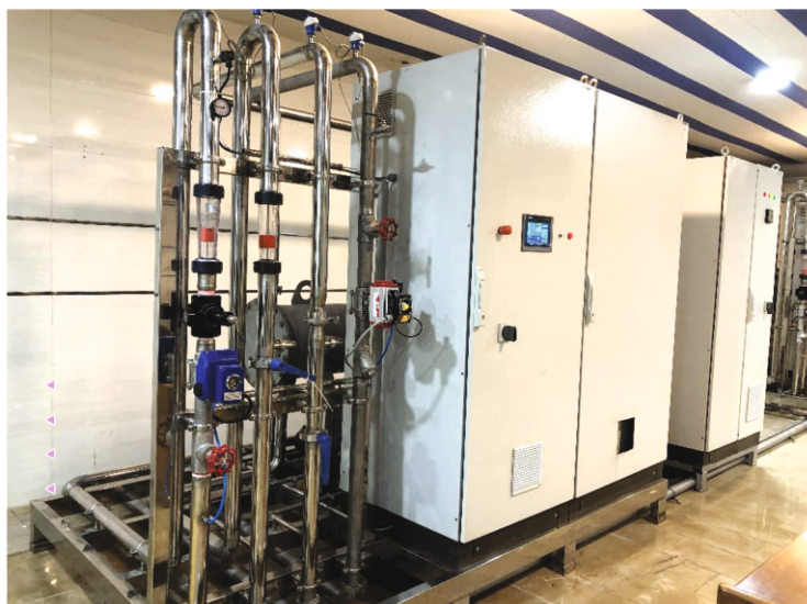
دارای تکنولوژی پیشرفته (corona discharge—micro gap) دارای میکروپروسسور داخلی با قابلیت کنترل توسط سنسور هزینه نگهداری کم و با قطعاتی با طول عمر بالا و استهلاک کم دارای سیستم خنک کننده همزمان آب و هوا
